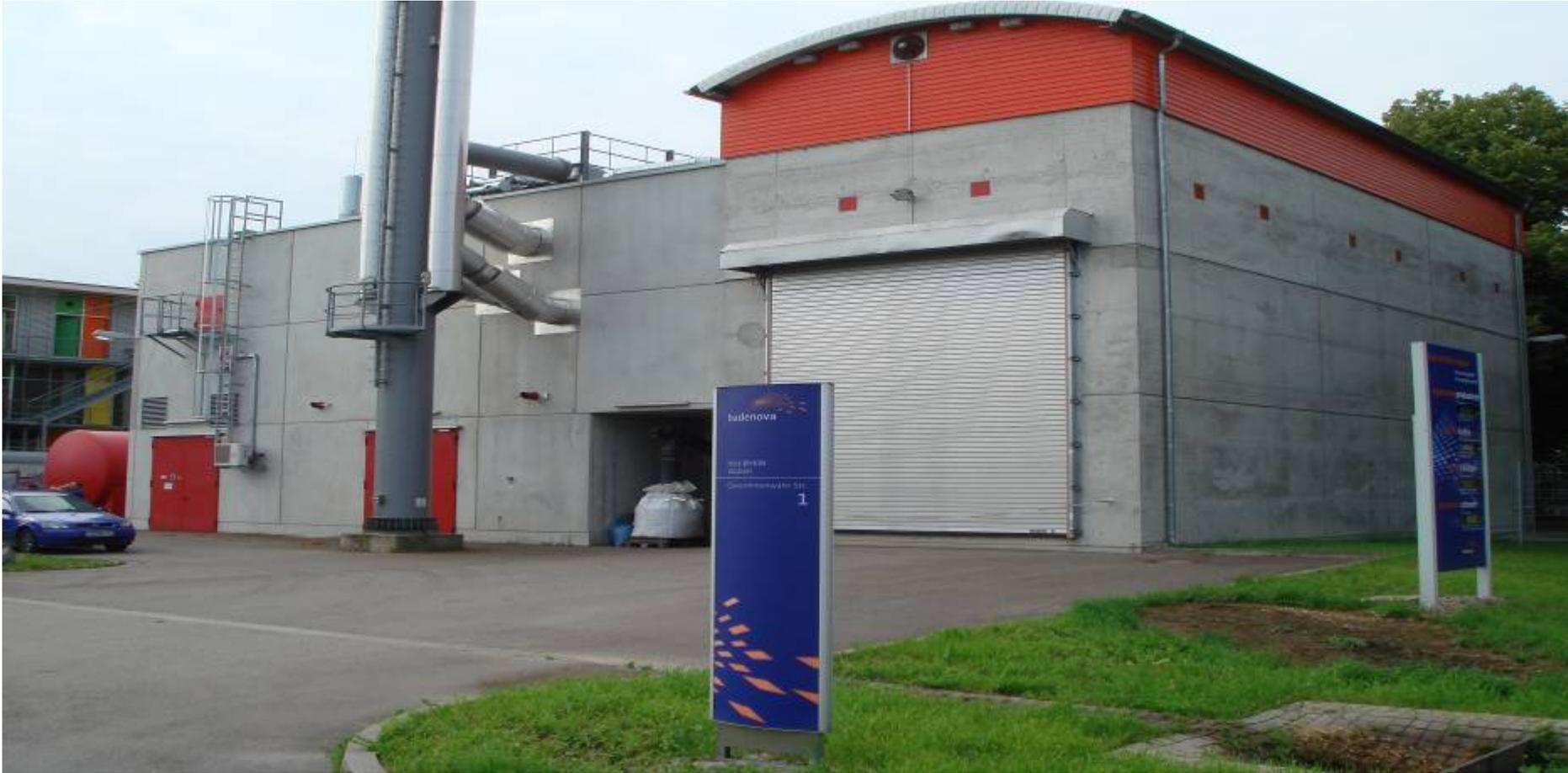
Cette chaufferie bois, qui fonctionne selon les principes de la cogénération, répond aux besoins en chauffage de 2000 logements et produit 30% des besoins en électricité du quartier. Le bois est 100% d'origine locale.
